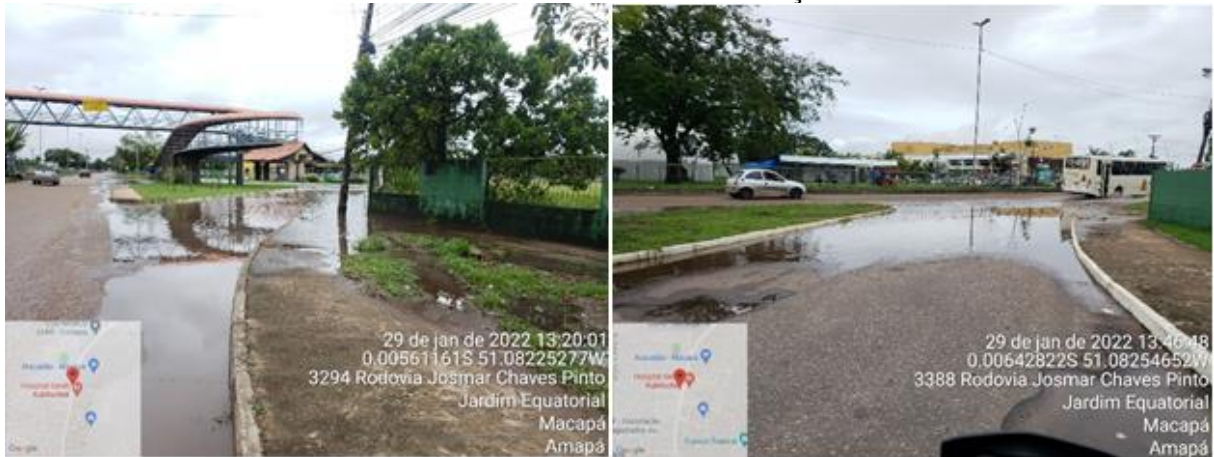
Imagem 8: Entrada (esquerda) e saída (direita) campus Marco Zero Rod. Josmar com solução em sumidouros e vala de infiltração.
