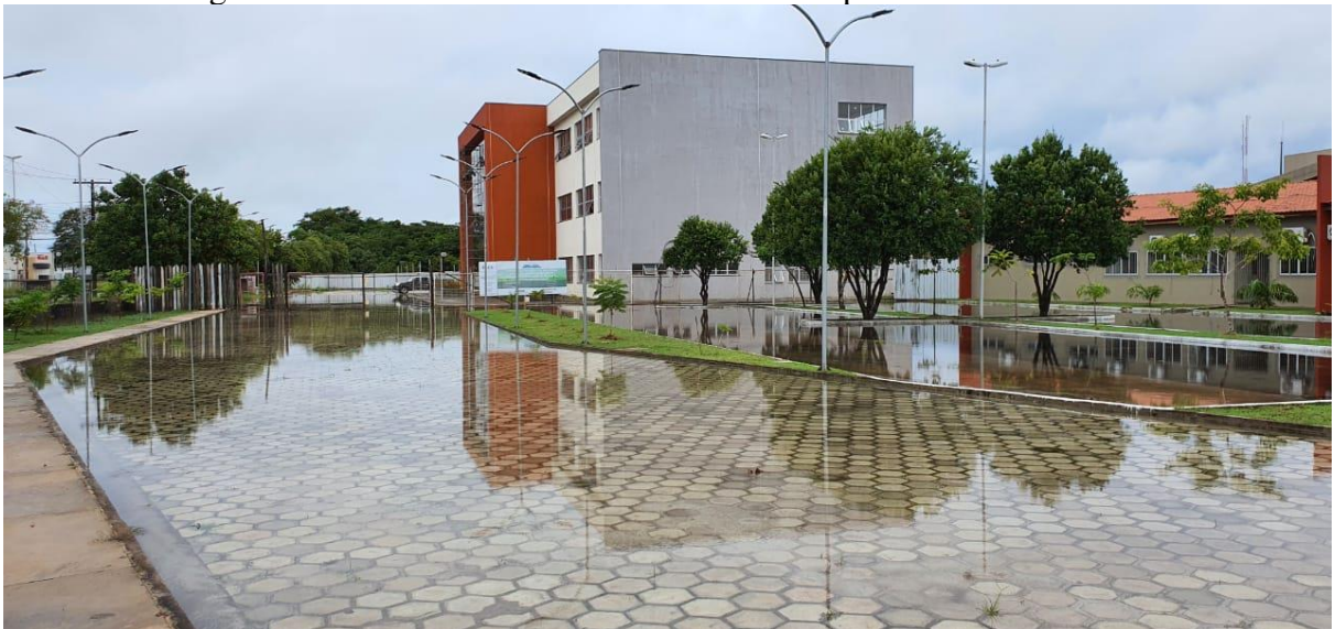
Imagem 6 - Acesso à nova biblioteca central em pavimento intertravado.
