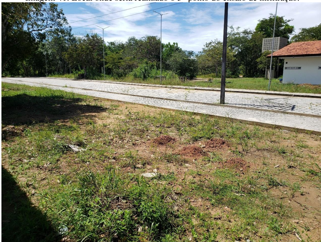
Imagem 41: Local onde seria realizado o 3º ponto do ensaio de infiltração.
