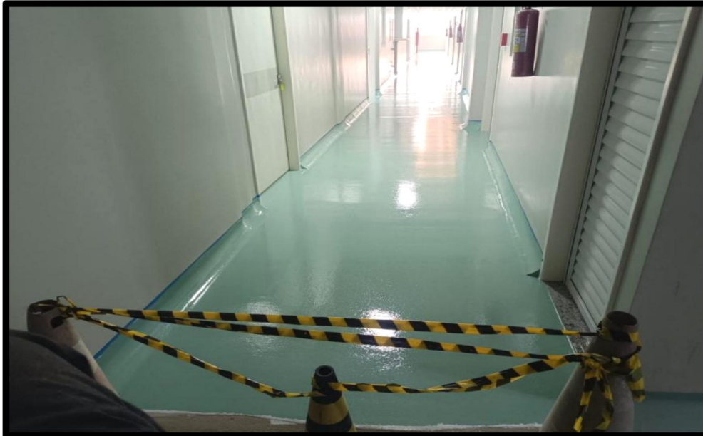
FIGURA 16- ETAPA 5: APLICAÇÃO DO REVESTIMENTO EPÓXI
