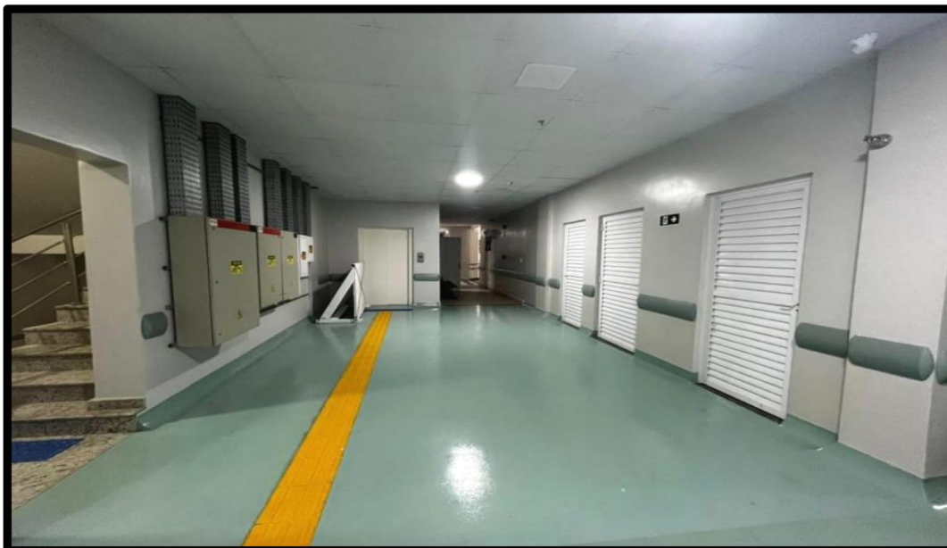
FIGURA 5 - PISO EPÓXI EM ROTAS ACESSÍVEIS
