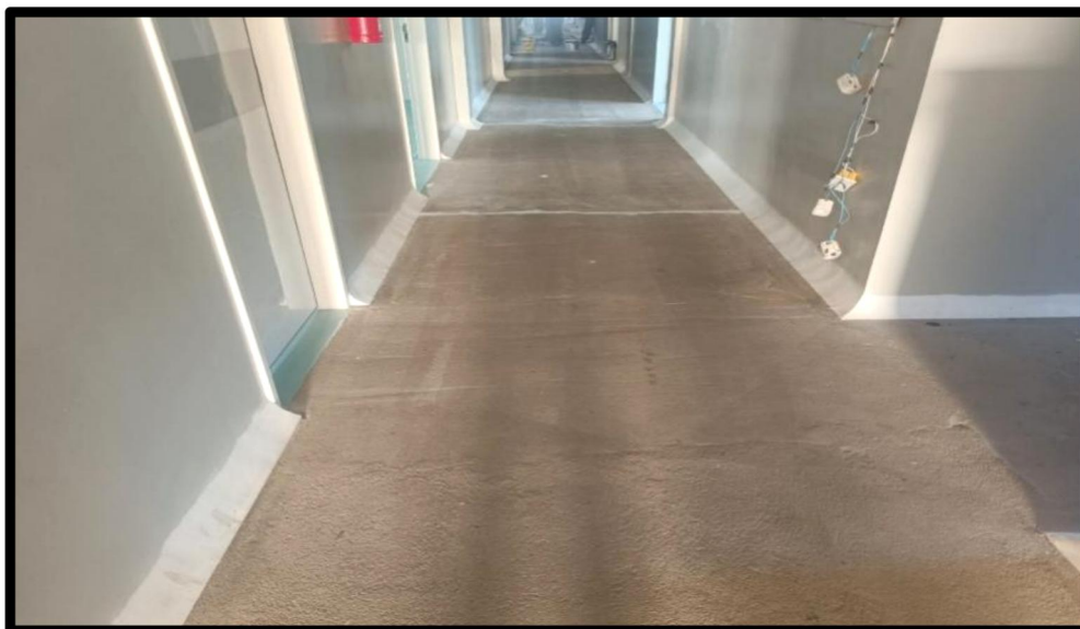
FIGURA 13 - ETAPA 2 - APLICAÇÃO DO PRIMER DE ADERÊNCIA AO SUBSTRATO.
