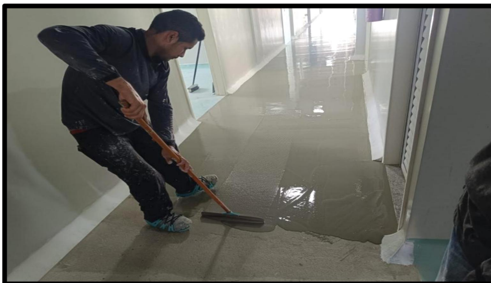
FIGURA 14 - ETAPA 3: APLICAÇÃO DA ARGAMASSA AUTONIVELADORA
