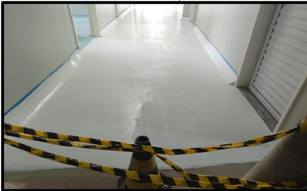
FIGURA 15- ETAPA 4: APLICAÇÃO PRIMER EPÓXI
