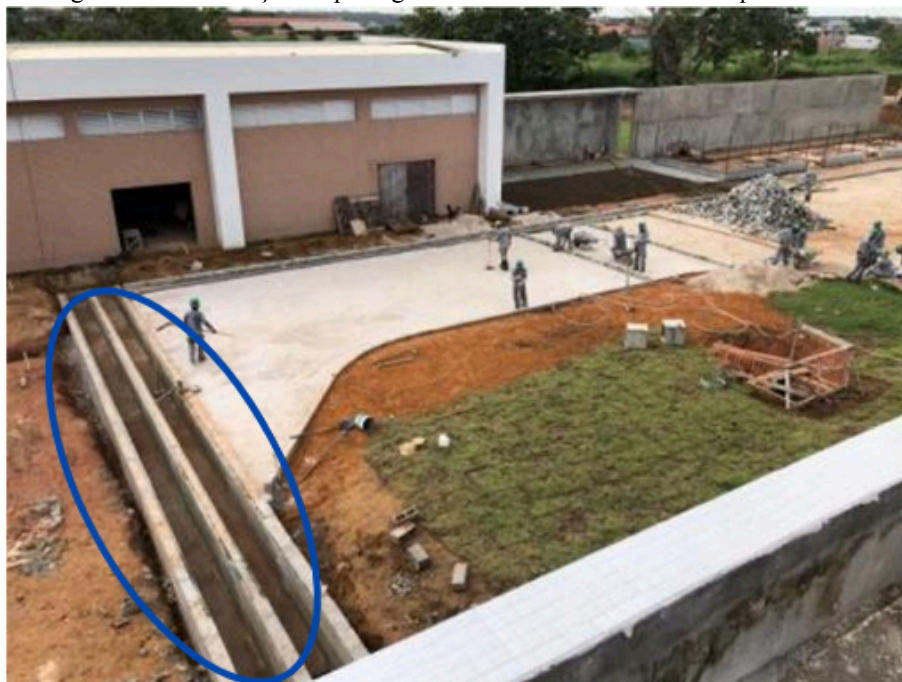
Figura 35 - Construção da passagem de cabeamento subterrânea para a CUT.
