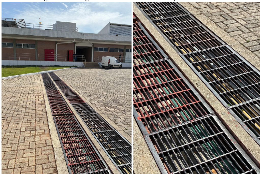
Figura 36 - Passagem de cabeamento subterrânea para a CUT.
