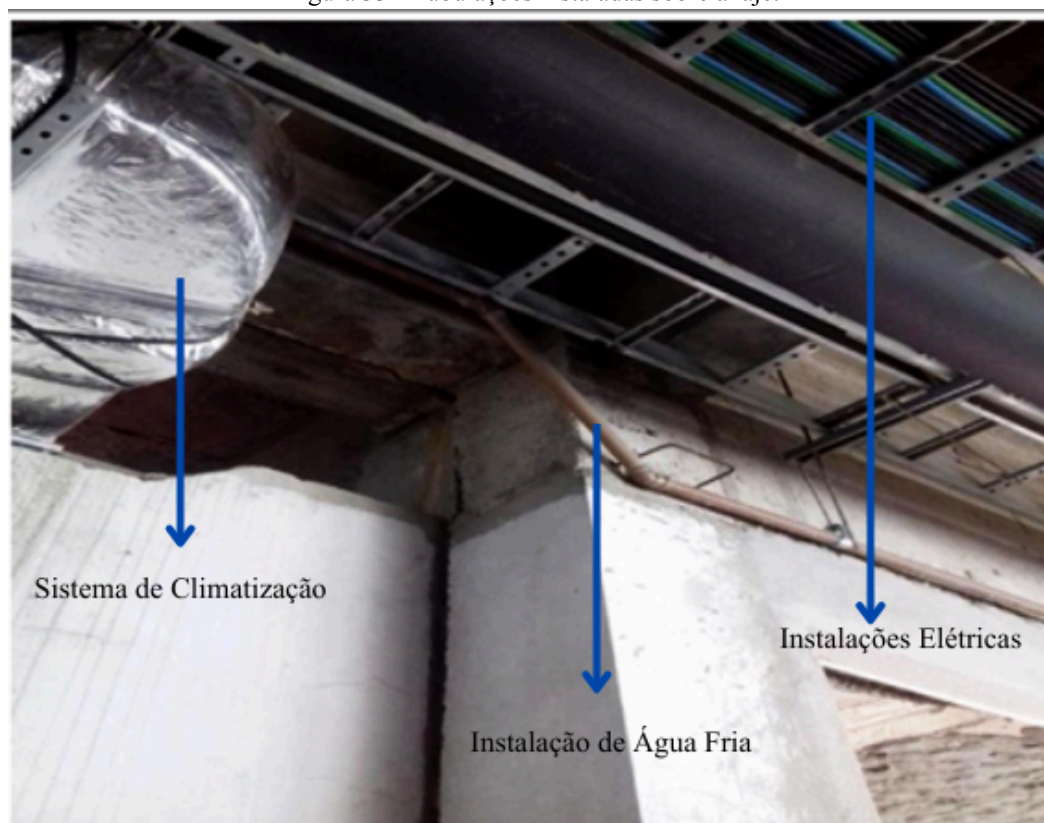
Figura 33 - Tubulações instaladas sobre a laje.
