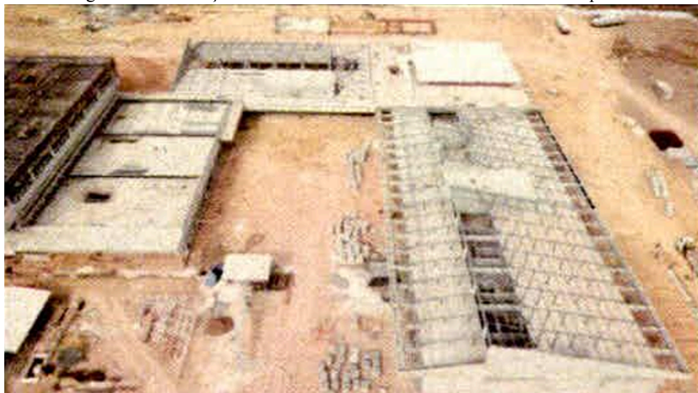
Figura 24 - Instalação da estrutura da cobertura do edifício - vista superior.
