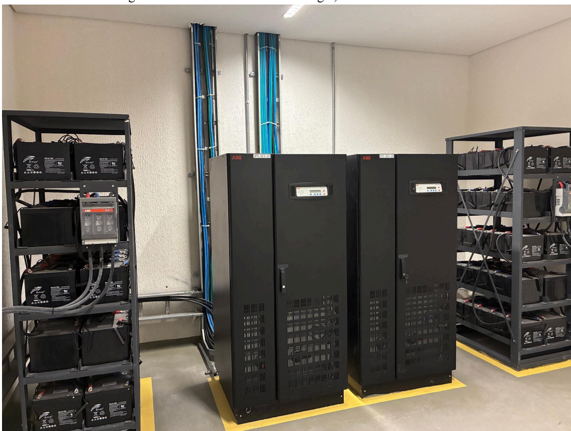
Figura B3- Banco de baterias de energia, com autonomia de 7h.
