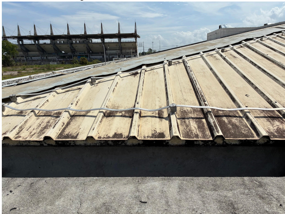
Figura I1 -Vista do telhado do HU-UNIFAP.
