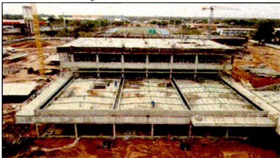
Figura 25 - Vista Panorâmica da obra.
