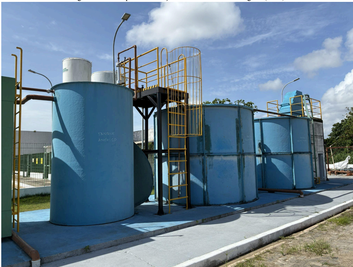
Figura B1 - Tanques da Estação de Tratamento de Esgoto (ETE).
