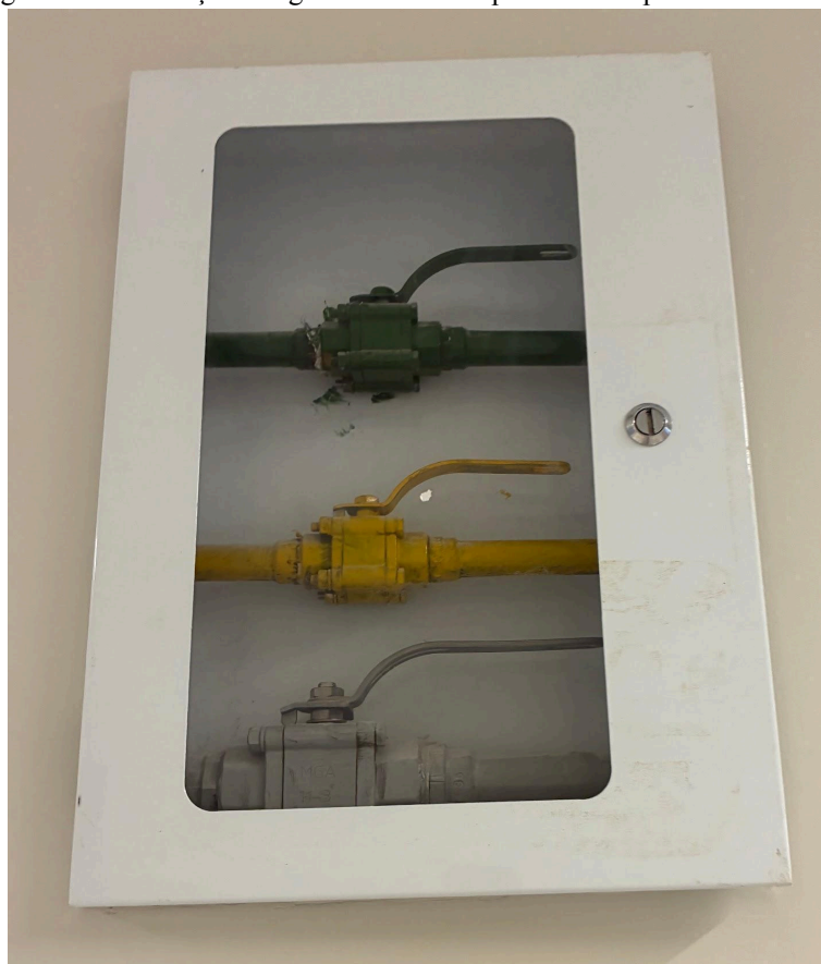
Figura C3 - Instalações de gases medicinais próximos ao ponto de consumo.
