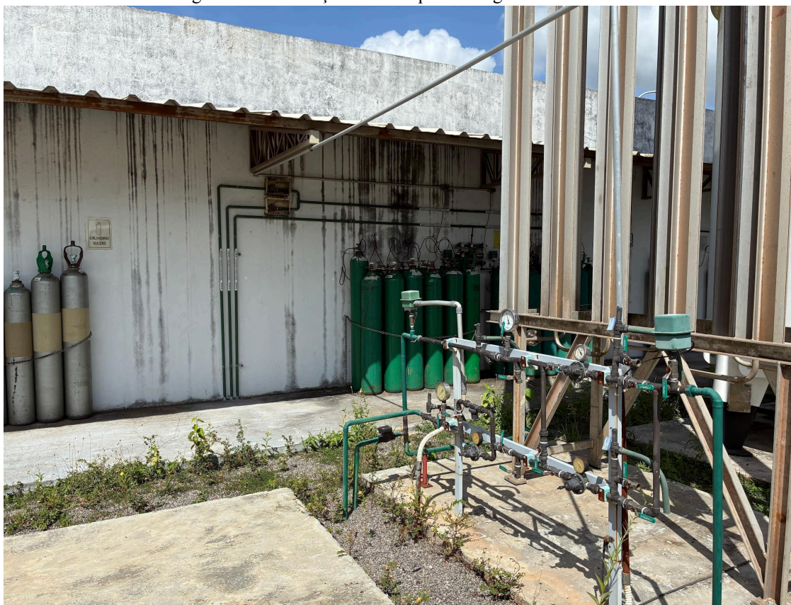
Figura C3 - Instalações de gases medicinais próximos ao ponto de consumo.
