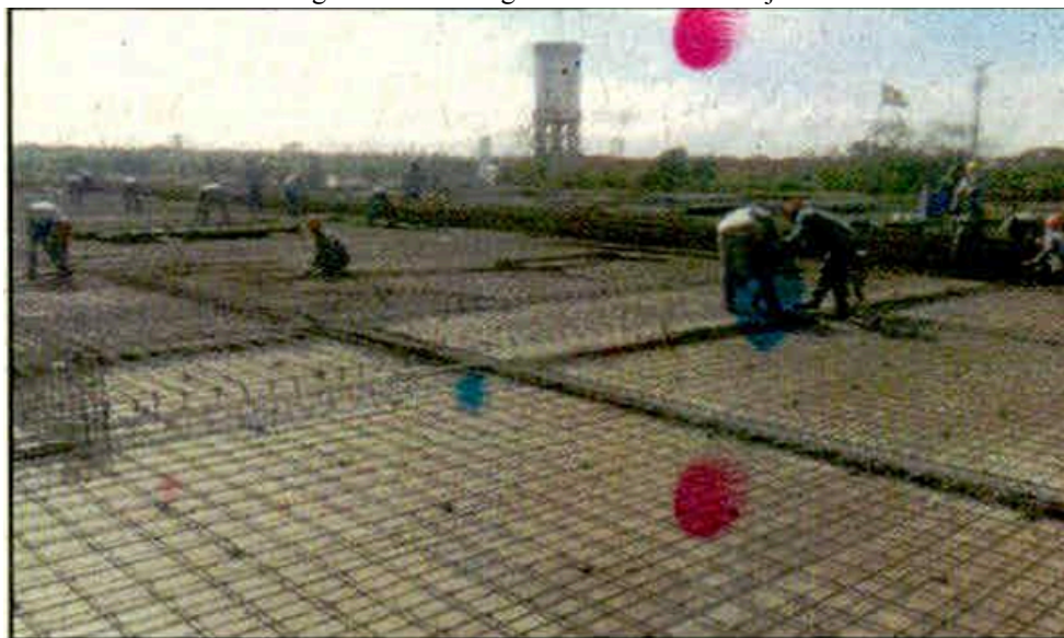
Figura 23 - Montagem de armadura de laje.
