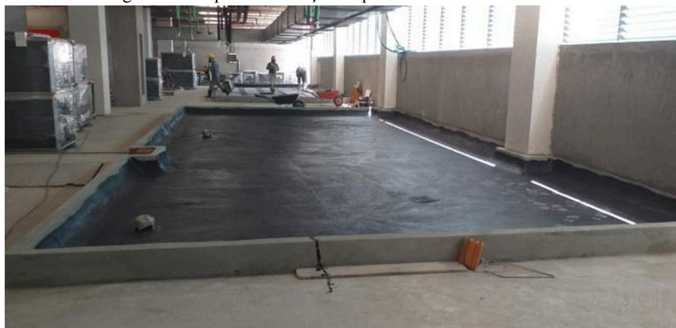
Figura 27 - Impermeabilização de piso no Pavimento Mecânico.
