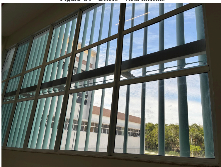
Figura G1 - Brises - vista interna.
