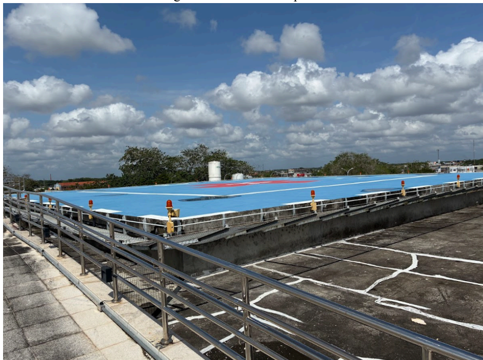
Figura J1 -Vista do Heliponto.
