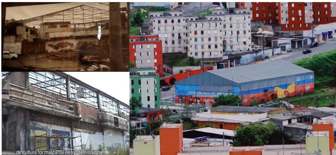
Figura 3 Galpão em ruínas. Pombas Urbanas 2008. Figura 4 Fachada Galpão em ruínas. Pombas Urbanas 2020. Figura 5 Centro Cultural Arte em Construção. Pombas Urbanas 2019.
