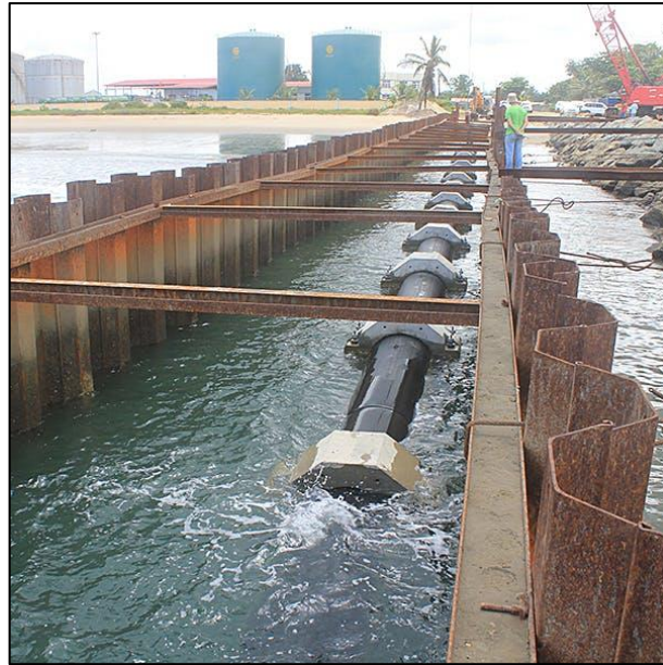
Figura 10 - Tubulação de PEAD do emissário de Bata (Guiné Equatorial)
