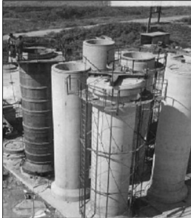
Figura 9 - Tubulação de concreto armado do emissário de Thessaloniki
