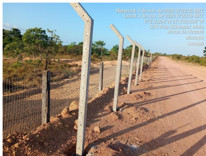
Figura 11 – Implantação e alinhamento dos postes da cerca operacional. Fonte: Elaboração da autora (2026)
