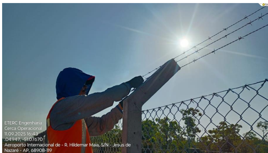
Figura 16 – Instalação de elementos de fechamento da cerca operacional – Arames Fonte: Elaboração da autora (2026)
