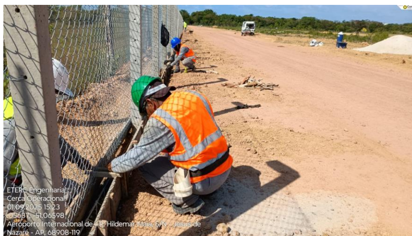
Figura 12 – Instalação de treliça na viga baldrame escavada Fonte: Elaboração da autora (2026)
