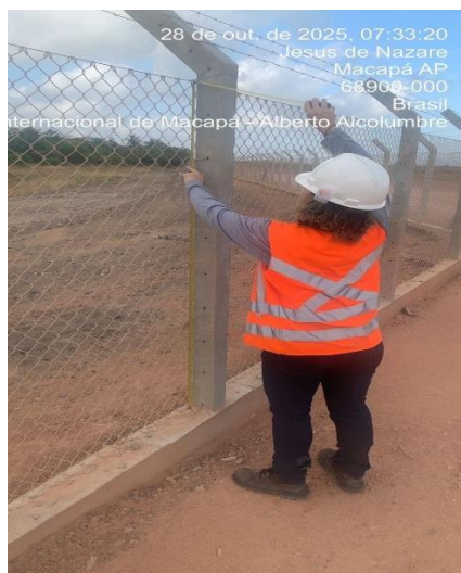
Figura 19 – Orientanda verificando medidas de tela alambrada conforme projeto Fonte: Elaboração da autora (2026)
