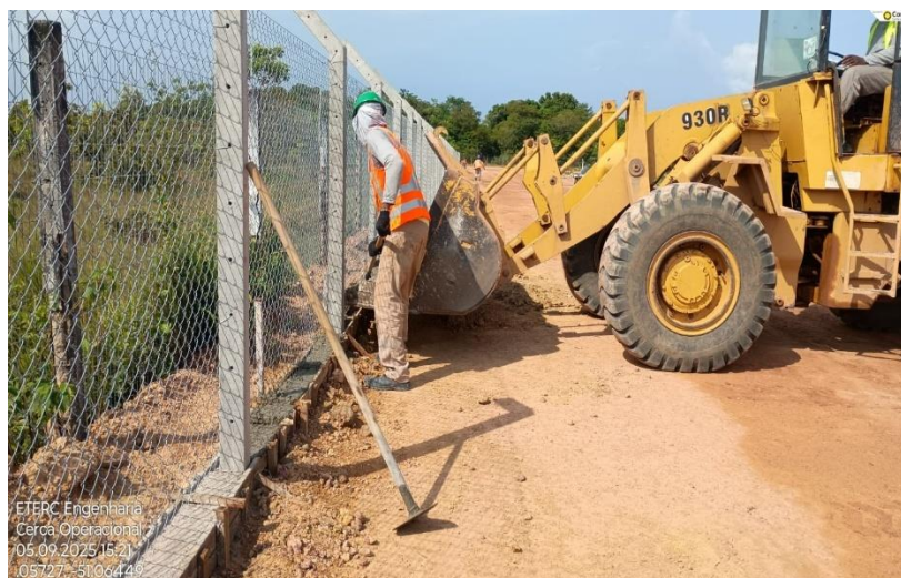
Figura 14 – Concretagem da viga Fonte: Elaboração da autora (2026)
