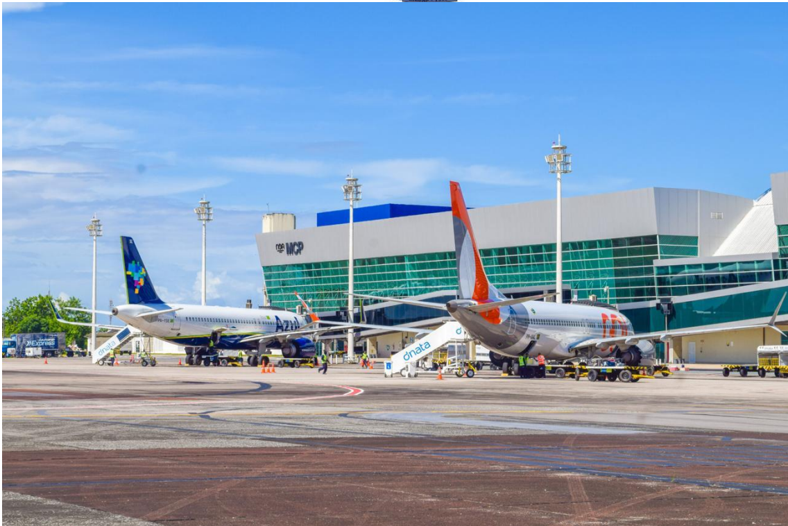
Figura 5 – Terminal de passageiros após as obras de modernização Fonte: NOA Airports (2026)
