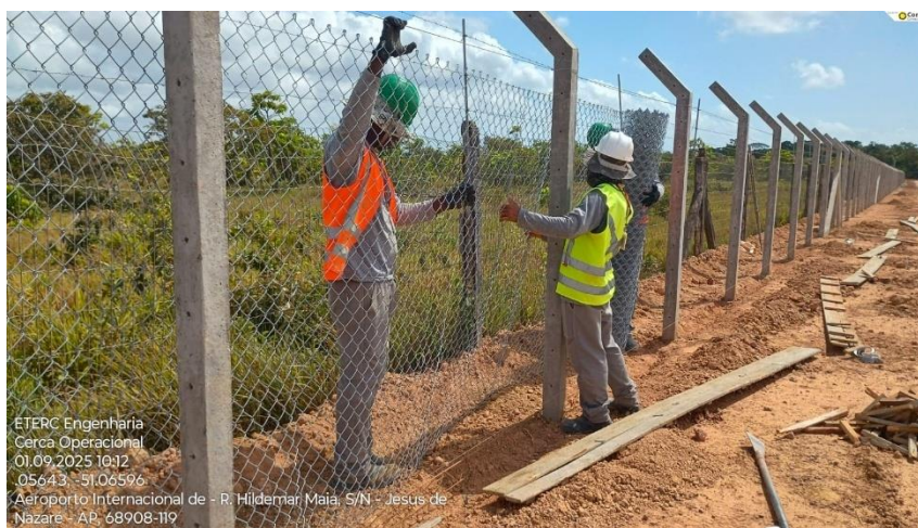
Figura 15 – Instalação de elementos de fechamento da cerca operacional – Alambrado Fonte: Elaboração da autora (2026)
