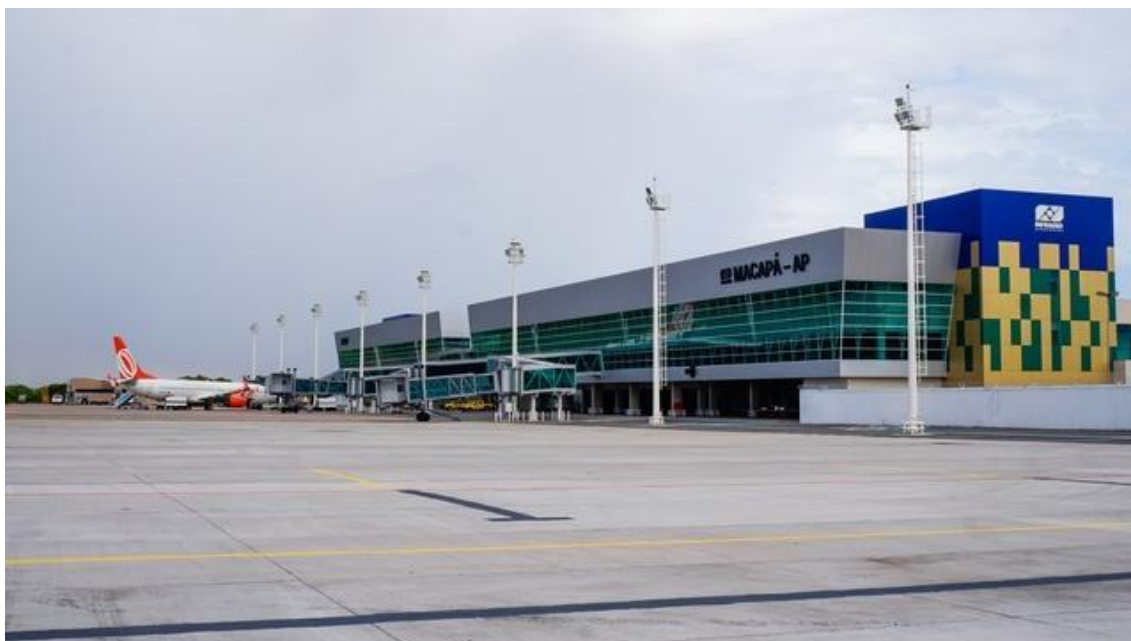
Figura 1 – Vista do terminal de passageiros do Aeroporto Internacional de Macapá – Alberto Alcolumbre
