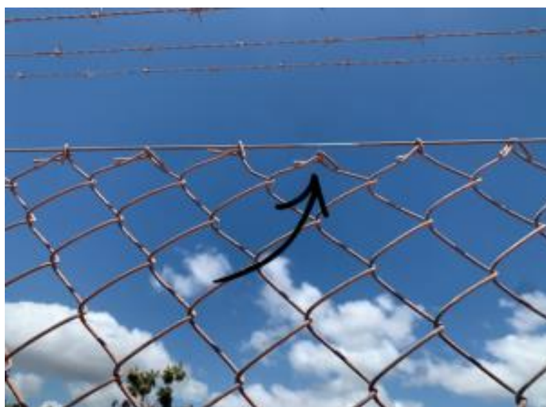
Figura 18 – Local de ajuste da fixação de arame
