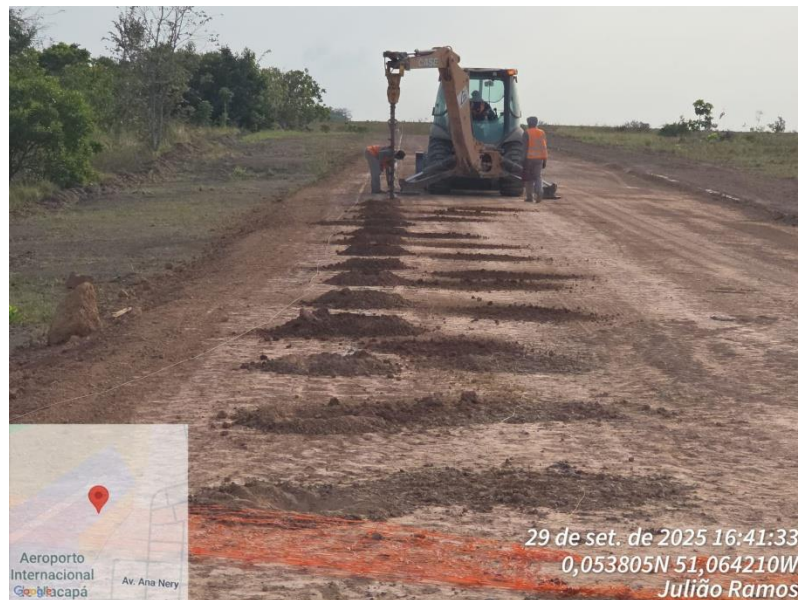
Figura 10 – Execução de fundação do poste com perfuratriz Fonte: Elaboração da autora (2026)
