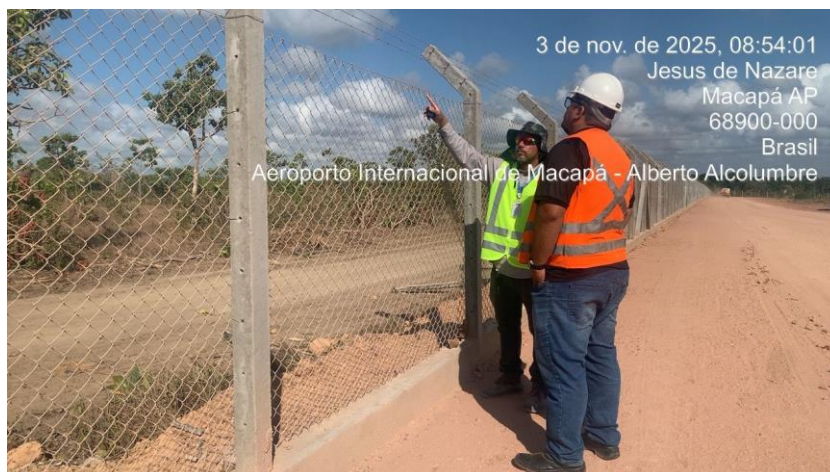
Figura 17 – Engenheiro responsável indica ao empreiteiro ajuste necessário na amarração do arame
