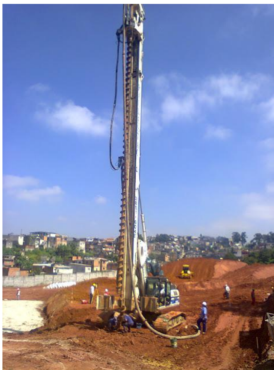
Figura 2 Maquinário para execução de estacas hélice contínua
