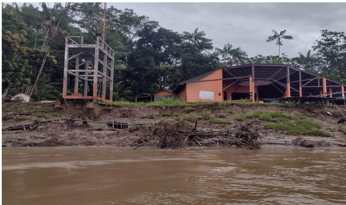
Figura 29: Módulo restaurante e estrutura de tratamento e distribuição de água da Escola-Bosque dias antes de serem completamente destruídos pela erosão
