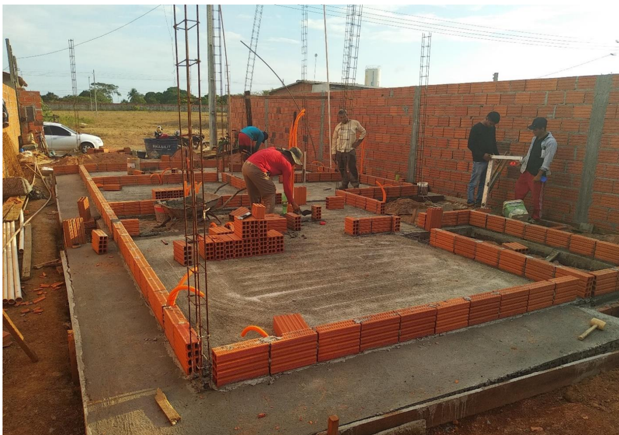
Figura 4 - Início da alvenaria, primeira fiada
