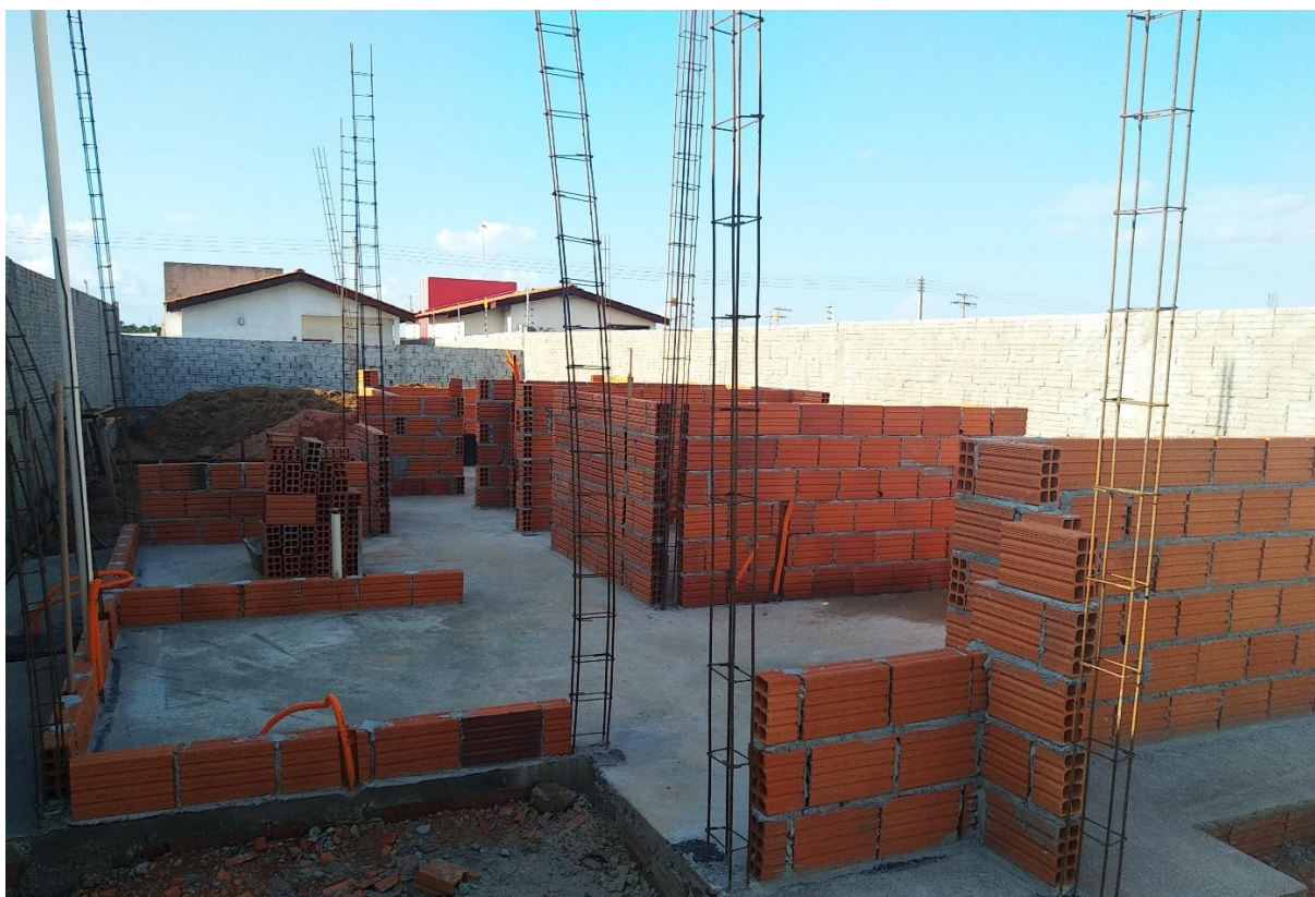
Figura 5 - Casa com paredes de 1,5m de altura
