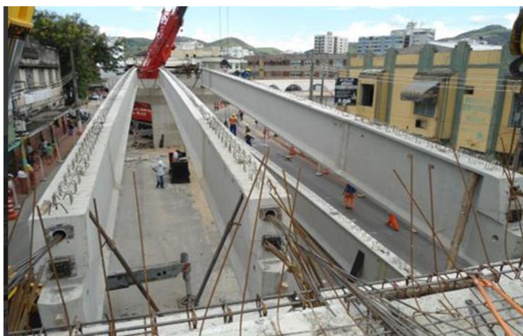
Figura 2.16 - Lançamento das vigas protendidas de 30metros ( www.Dimensionalengenharia.com )
