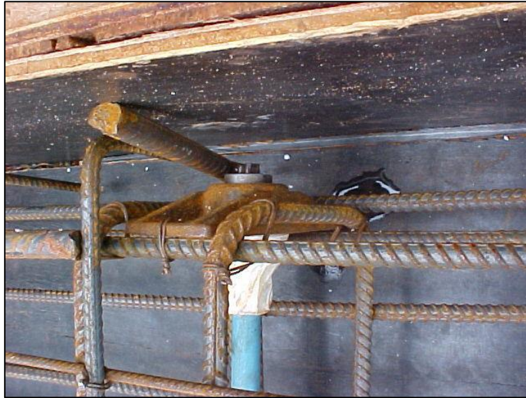
Figura 2.19 - Ancoragem passiva de cordoalha engraxada (BASTOS, 2018).
