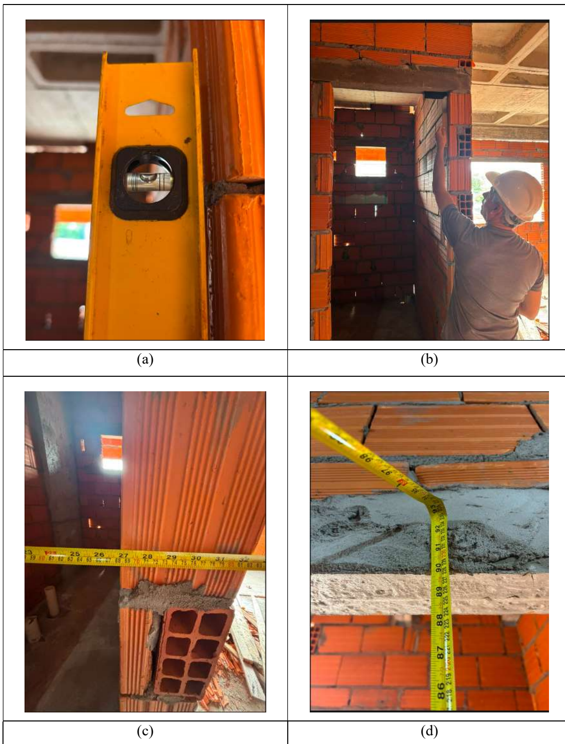
Figura B7 — Ed. Studio Way. Vão 07: (a) nível; (b) esquadro; (c) largura e (d) altura.
