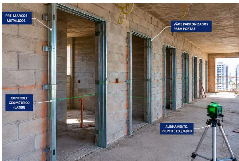
Figura 13 — Pré-marcos metálicos e controle geométrico preventivo - execução de vãos.
