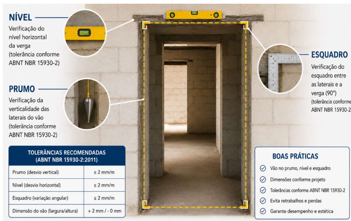
Figura 08 — Nível, prumo e esquadro aplicados à execução de vãos.
