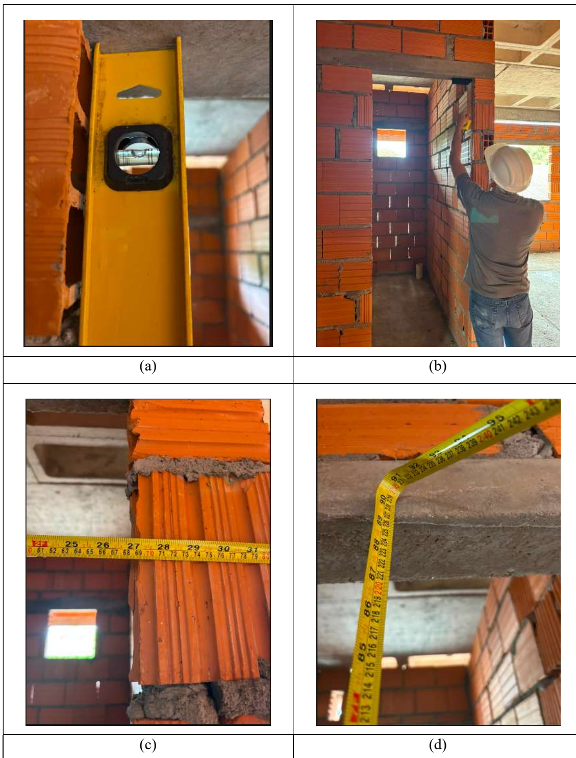
Figura B6 — Ed. Studio Way. Vão 06: (a) nível; (b) esquadro; (c) largura e (d) altura.
