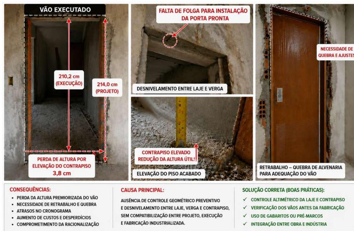
Figura 15 — Incompatibilidade dimensional entre o vão e a porta-pronta em MDF.
