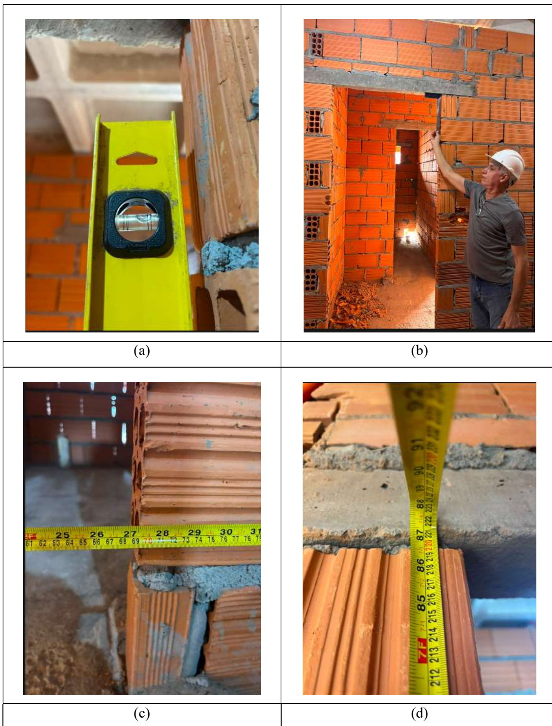
Figura B2 — Ed. Studio Way. Vão 02: (a) nível; (b) esquadro; (c) largura e (d) altura.
