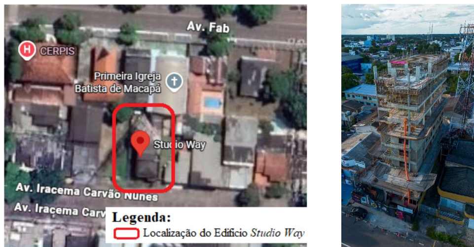
Figura 03 — Ed. Studio Way : (esq.) localização e (dir.) vista geral da obra em execução.
