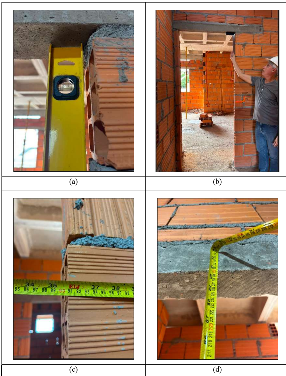
Figura B3 — Ed. Studio Way. Vão 03: (a) nível; (b) esquadro; (c) largura e (d) altura.
