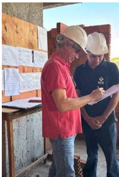
Figura 16 — Visita técnica e entrevista estruturada na obra do Ed. Studio Way .
