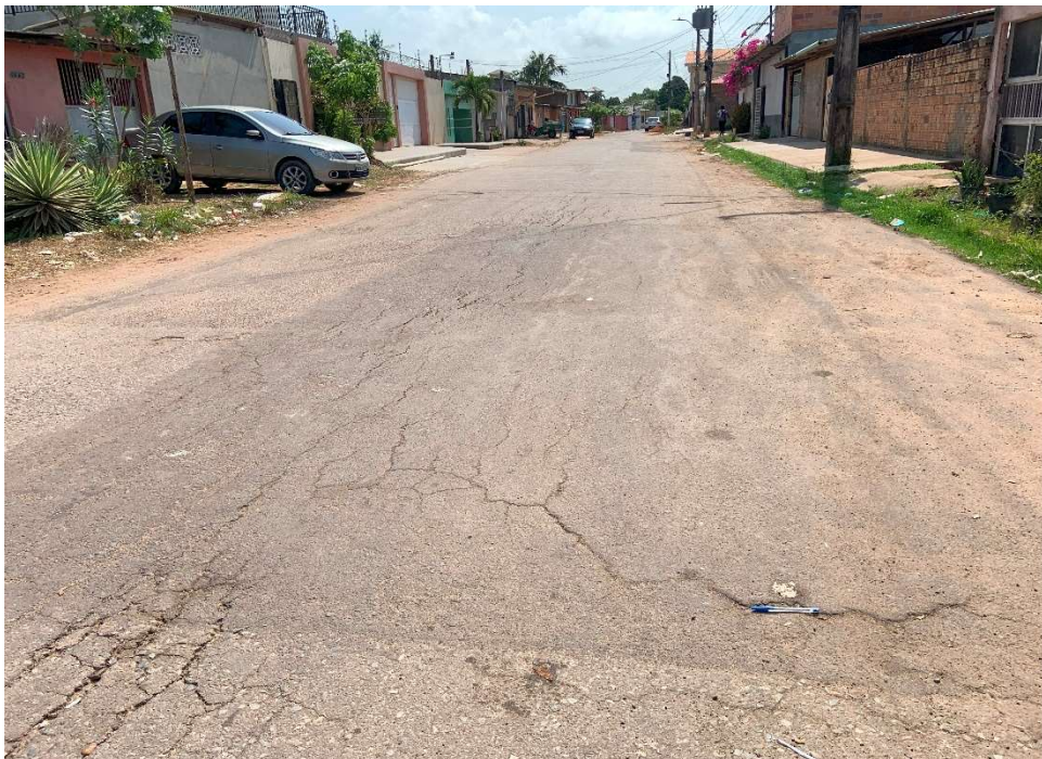
Figura 10: Trincas Transversais, Trincas Longitudinais, Trincas de fadiga, Remendo, Agregado Polido, Corrugações.
