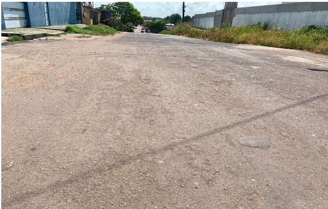
Foto 1 - Agregado Polido, trilha de roda.
