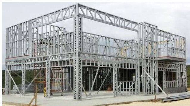
Figura 4 - Sistemas modulares de elementos.
