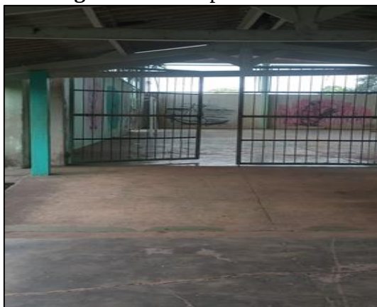
Figura 35 - Rampa de acesso
