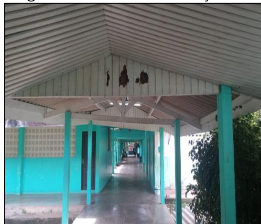
Figura 34 - Piso sem sinalização tátil
